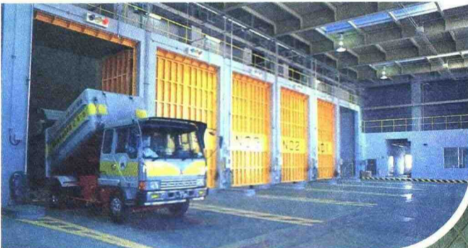
投入ステーション 収集車が搬入したごみは、ごみ投入扉からごみピットへ投入されます。ごみピット内の臭気は、投入扉やエアカーテンで外気と断り、ピット内を真空に保つことにより外部に漏らさないようになっています。
