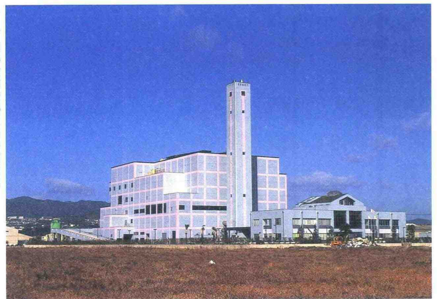
▲3/25●南部清掃工場の落成式 最新鋭のごみ処理工場として1号用地に完成。近年のごみ量の増加とごみ質の多様化に対応します。
