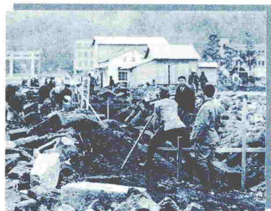
▲照国神社前の側溝工事 (昭和21年)
