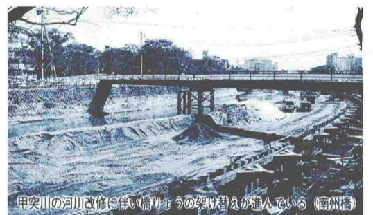
甲突川の河川改修に伴い橋りょうの架け替えが進んでいる(南州橋)
