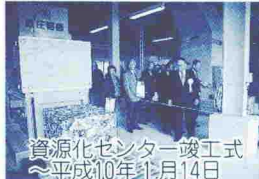
資源化センター竣工式 ～平成10年1月14日
