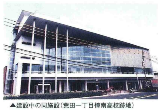
▲建設中の同施設(荒田一丁目樟南高校跡地)
