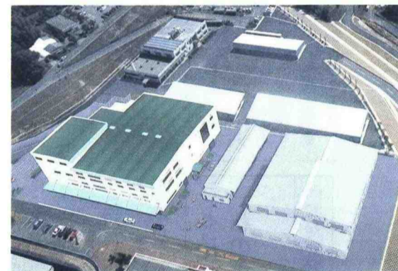
10月30日 リサイクルプラザ(仮称)着工 分別収集した缶、びん、ペットボトル、紙パック、その他プラスチック製容器包装を資源化するリサイクルプラザの建設に着工しました。平成14年2月末に完成する予定です。
