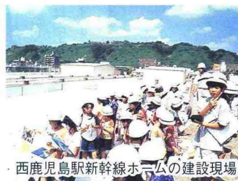
西鹿児島駅新幹線ホームの建設現場
