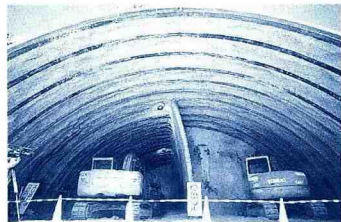
幹線道路の整備 ～武岡線のトンネル工事
