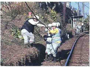
二軒茶屋付近でのケーブル張り替え作業
