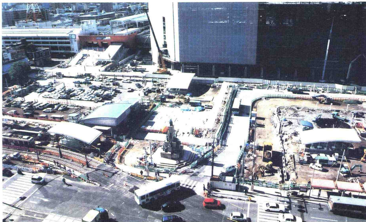
3月6日に向け急ピッチで整備が進む東口駅前広場
