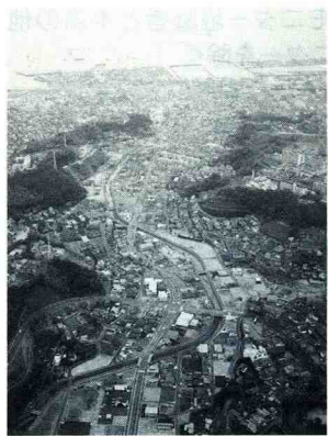
改修が進む協田川
