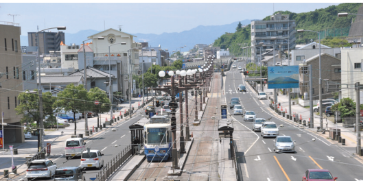
専用軌道から道路との併用軌道となった郡元~涙橋電停間。平成23年度には軌道敷が緑化される予定
