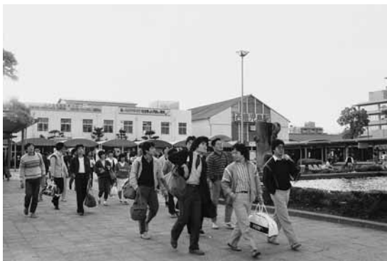
三角屋根がシンボルだった 旧西鹿児島駅舎 (昭和58年撮影)
