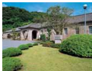
旧集成館機械工場
