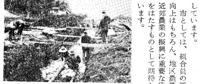
(はじめた排水路工事)
