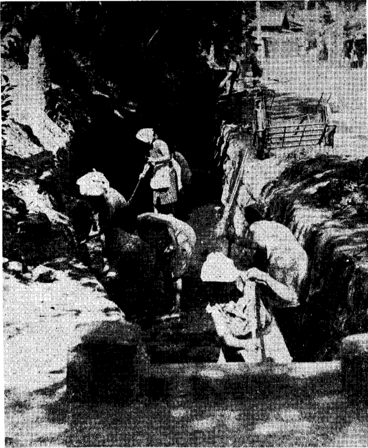
(側溝の清掃をする常盤町内会の人たち)
