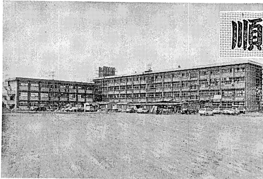
原良団地の中央部に建設中の明和小学校
