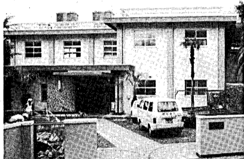
新装なった天保山分庁舎
