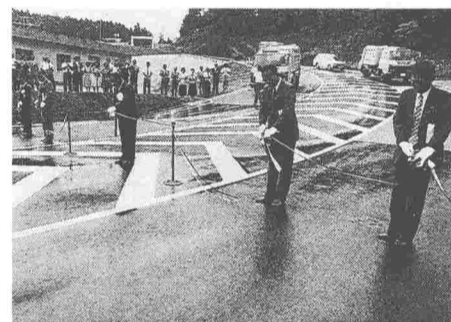
完成した横井埋立処分場（1工区）
