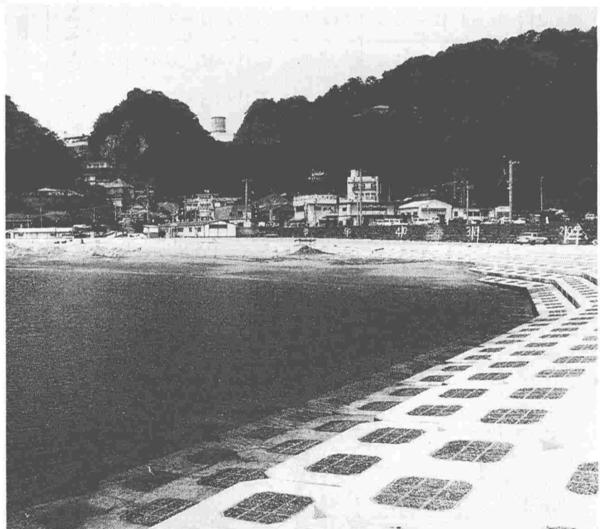
整備完了間近の磯海水浴場
