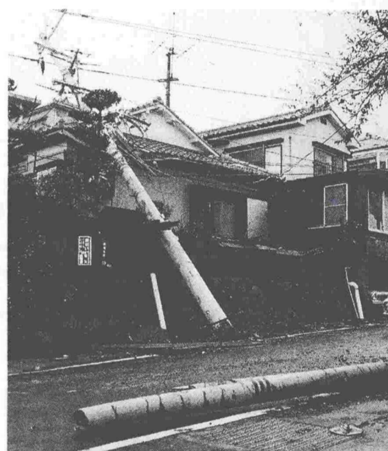
60年13号台風で倒れた電柱
