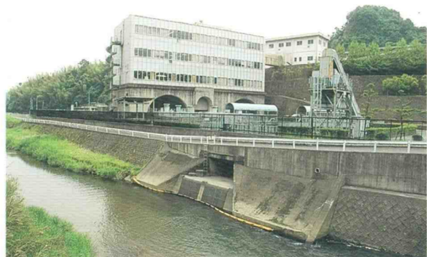
■甲突川を水源とする河頭浄水場。日量11万㎡の浄水能力をもつ。
