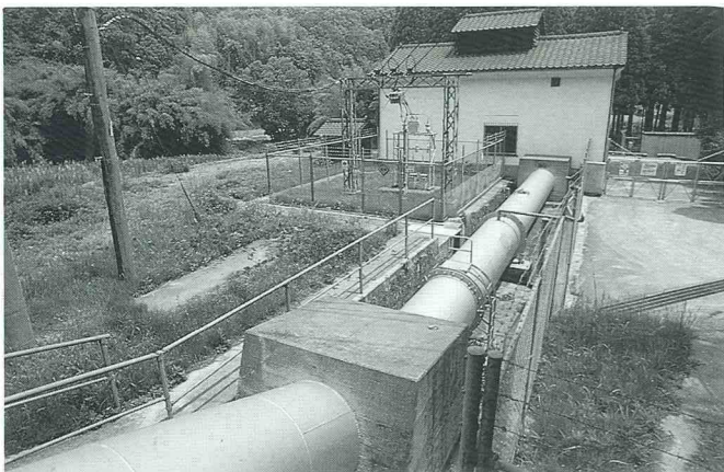
■小山田発電所
