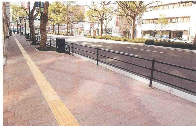
■透水性のある素材で歩道を整備(ナポリ通り)
