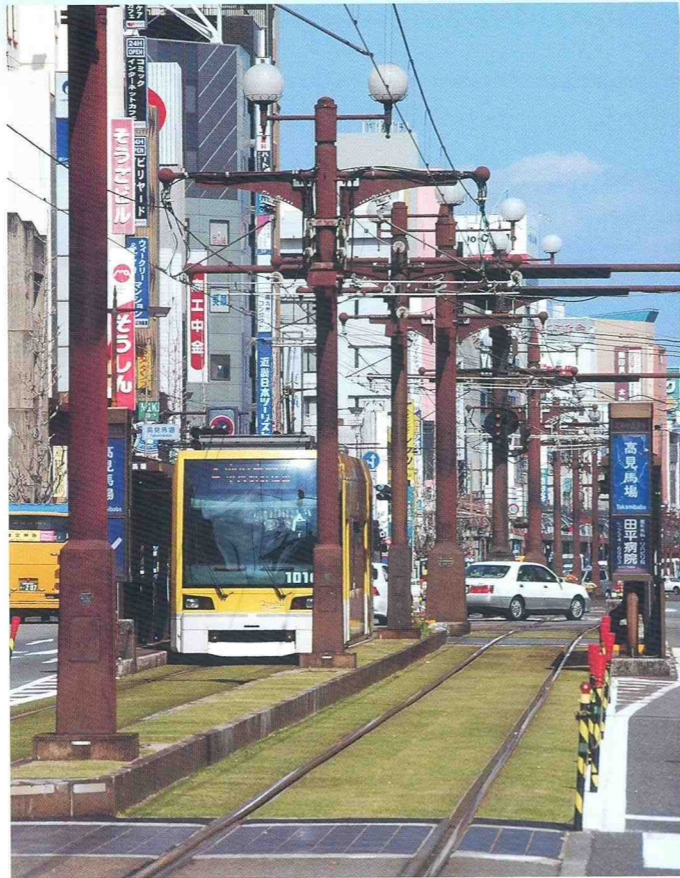
■平成18年度は鹿児島中央駅から高見馬場交差点までの軌道敷を緑化。
