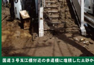
国道3号五江橋付近の歩道橋に堆積した土砂から、2mを超える高さまで浸水したと思われる
