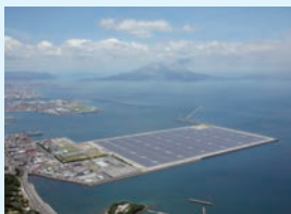
鹿児島七ツ島メガソーラー発電所
