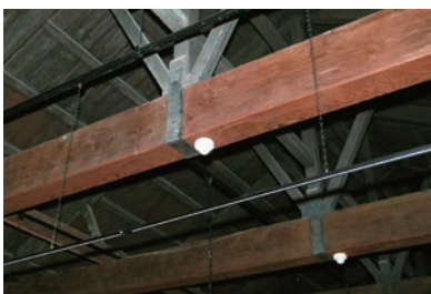
内部の太い梁
