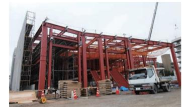
◀現在は整備工場のほか、局舎、神田変電所の基礎部分が建設されています。工事の状況は、市交通局ホームページからもご覧いただけます
