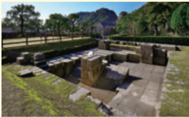
反射炉の基礎部
