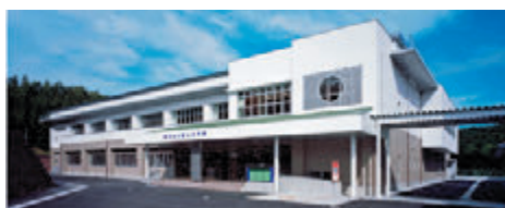
オープンを間近に控えた郡山体育館
