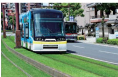
シラスが原料のブロックを使用している市電の軌道敷緑化の基盤
