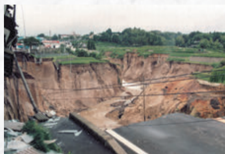
小山田町の国道3号が甲突川に削られ崩落
