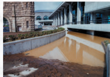
浸水した鹿児島アリーナ地下駐車場
