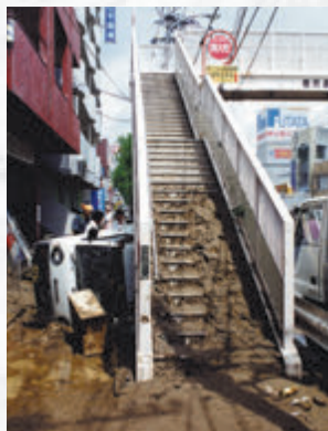
土砂が2m近くまで堆積した玉江橋付近の歩道橋
